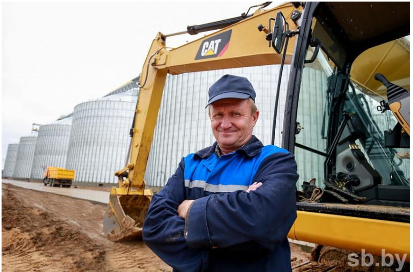
На стройплощадке Белорусской национальной биотехнологической корпорации работает машинист экскаватора Леонид Суховаров.
