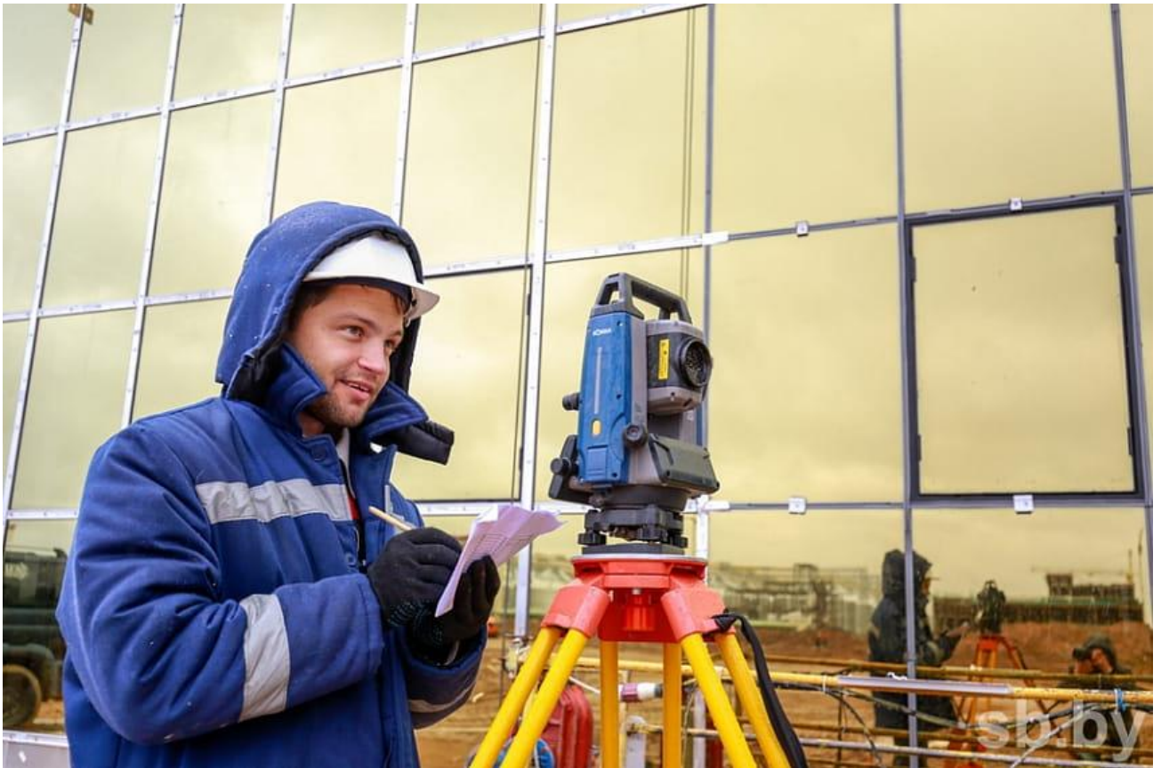
На строительной площадке БНБК геодезист Дмитрий Прохорчик.
